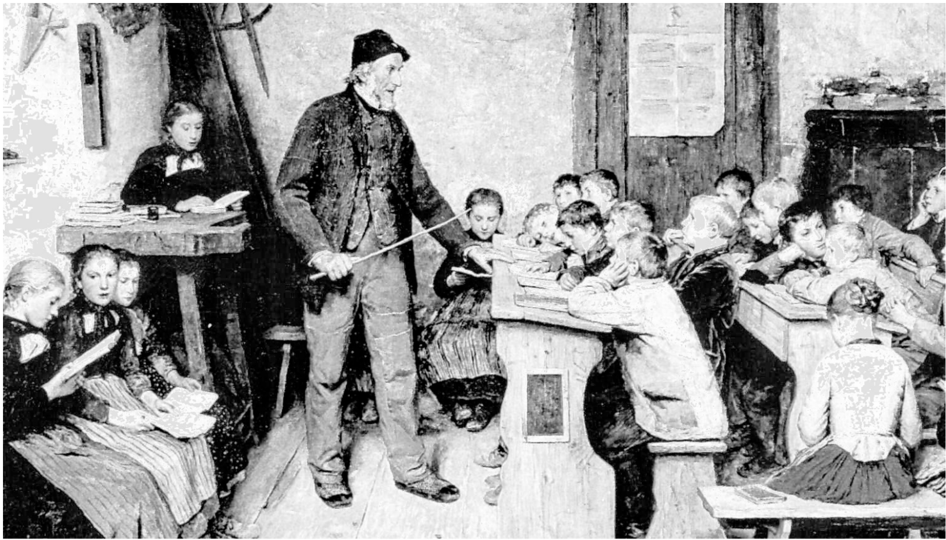
Das Bild vom Unterricht in einer Dorfschule um 1850, also rund 40 Jahre nach der hier beschriebenen Zeit, war in einer Sonderausstellung im Schulmuseum in Sendelbach zu sehen. So gut ausgestattet darf man sich die Schulzimmer im Lehrerhaus während der Zeit des badischen Amts freilich nicht vorstellen. FOTO: SCHULMUSEUM
